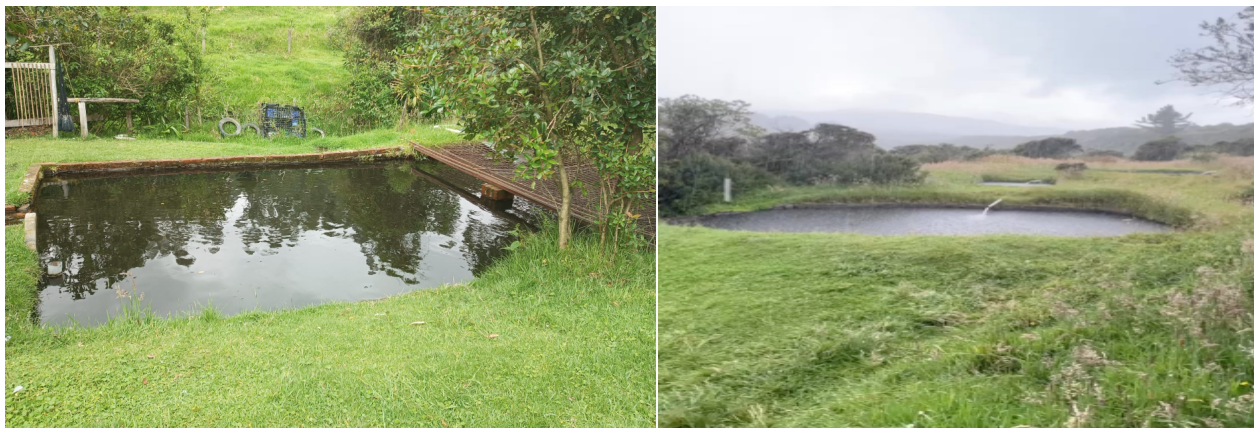
Fuente: Archivo Levantamiento Fotográfico, 2024 Elaborado por: Equipo Consultor, 2024
