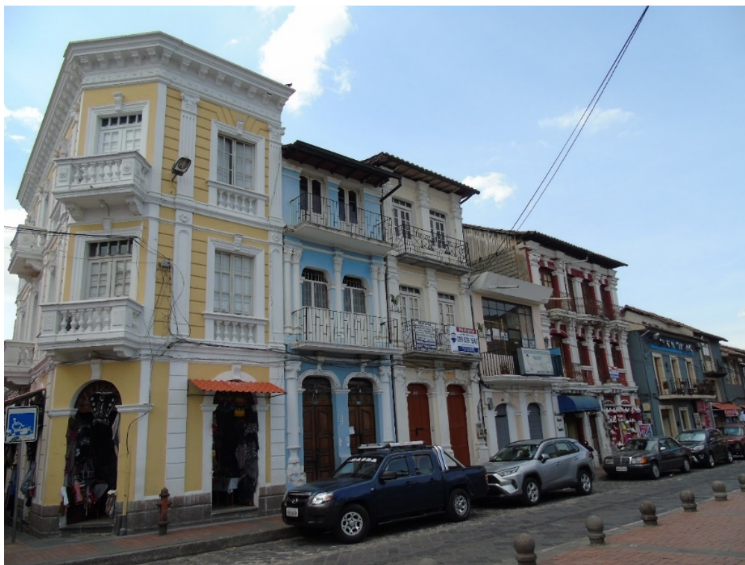
Fotografía 14: Edificaciones del Centro Histórico de Sangolquí
